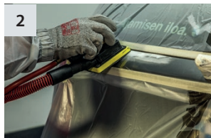
2 Spachtel ebnen und Übergänge schleifen OSP-3, OSP-4
