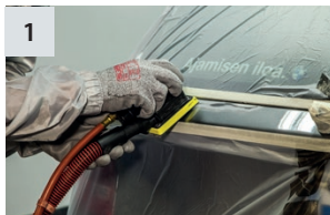
1 Lack entfernen und Übergänge schleifen OSP-2, OSP-3
